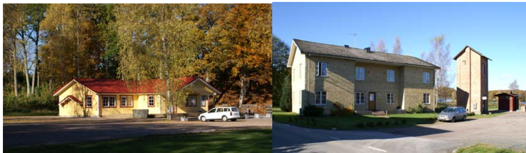
Befintlig bebyggelse med kanotcentrat, flerbostadshuset och det f.d pumphuset numera stenmuseum
