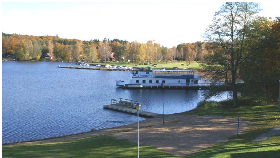
Immelnbåtens nuvarande angöringsplats med hamnen i bakgrunden sedd från kioskbyggnadens terrass
