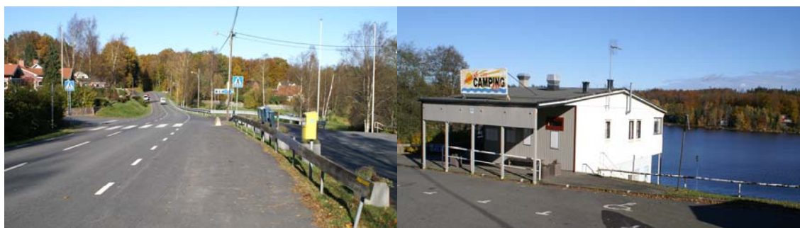
Väg 2056/Immelnvägen i anslutning till kioskbyggnaden och nuvarande badplatsen
