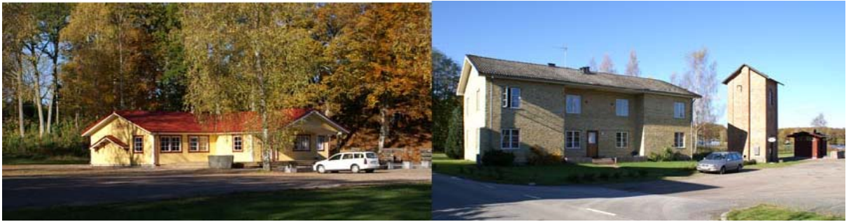
Befintlig bebyggelse med kanotcentrat, flerbostadshuset och det f.d pumphuset, numera stenmuseum
